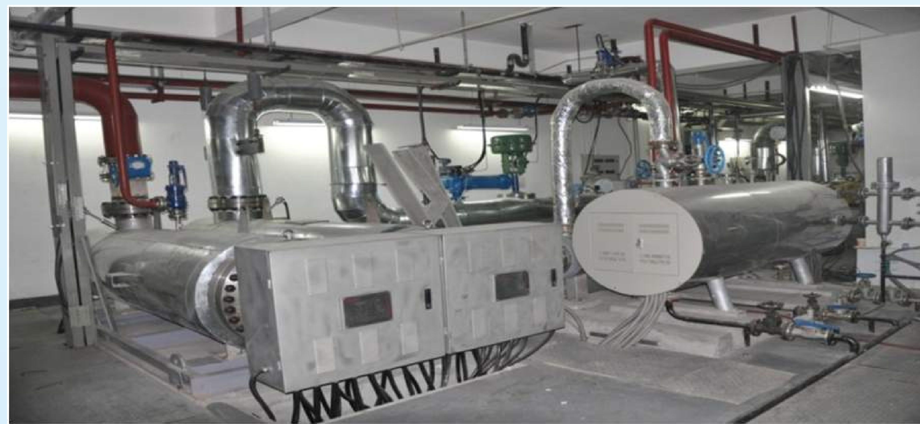
装备冷却技术实验平台
